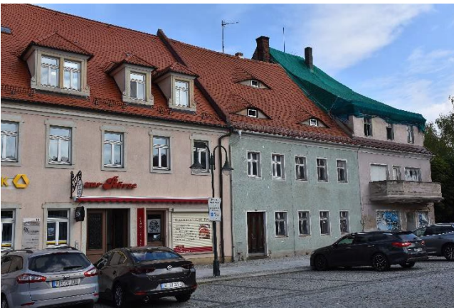
Bebauung auf der Nordseite des Marktes (teilweise leerstehend)
