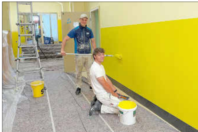
Mitarbeiter der Firma Klang beim Erneuern des Flurs in der Grundschule Oberottendorf
