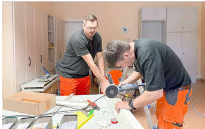
v. l. Daniel Gebauer und Jörg Hippe erneuern die Elektrik, bevor noch gemalt werden muss
