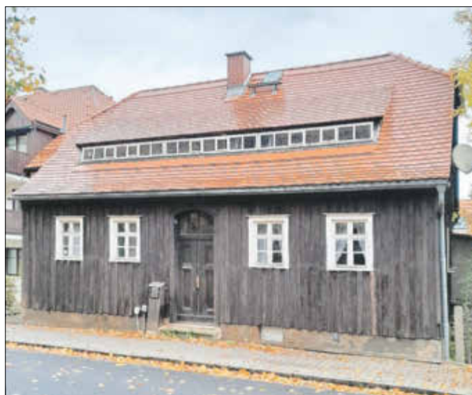
Das „Dammhäusel in Neustadt“
