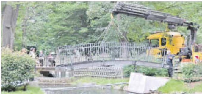
Probeweise Einpassung der neuen Bogenkonstruktion
