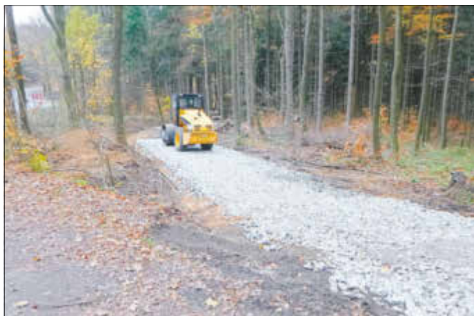
Aufbringen der Schotterdecke auf den Radweg
