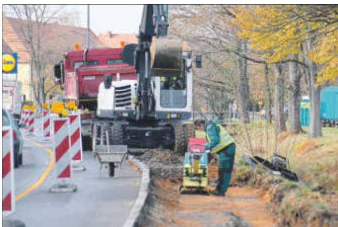
Einbau des Frostschutzes in den Gehweg, Foto: W. Thalheim
