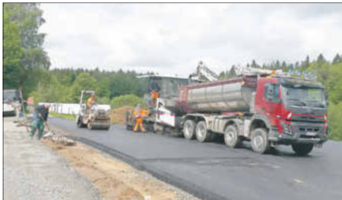
Asphalteinbau am 29. Mai 2019
