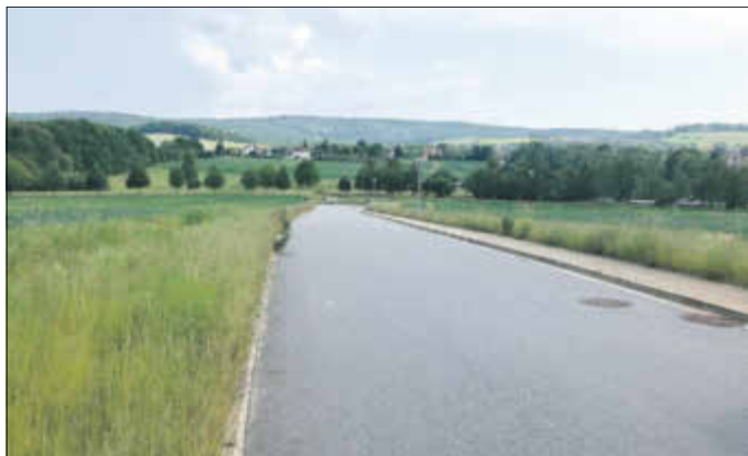
Blick auf einen Teilabschnitt der Heinrich-Hertz-Straße
