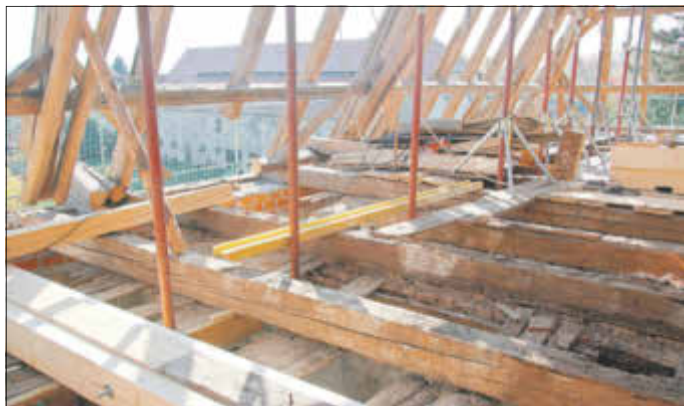
Blick auf die freigelegten Deckenbalken sowie die noch zu reparierenden Traufanschlüsse
