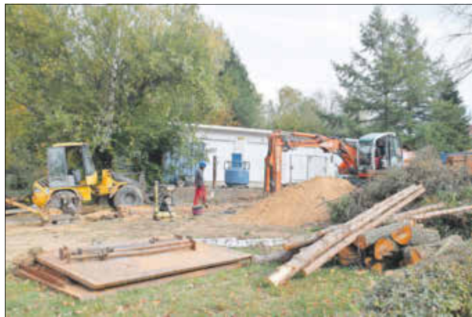
Erdaushubarbeiten zur Neuverlegung der Schmutz- und Regenwasserleitungen, Foto: Werner Thalheim
