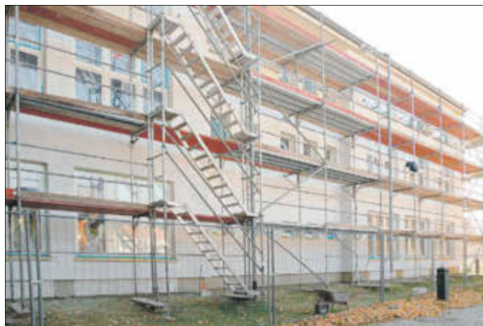
In der vergangenen Woche erfolgten die Malerarbeiten an der Fassade
