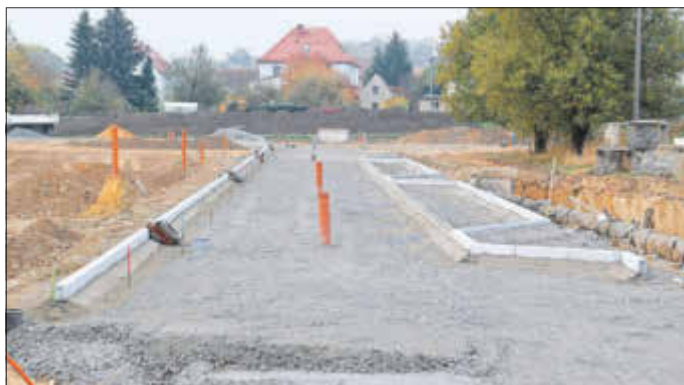
Die neue Straßenanbindung zur Berghausstraße ist bereits sichtbar, Foto: Werner Thalheim
