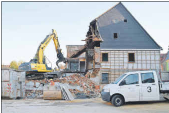
Abriss Böhmische Straße 17 am 17. Oktober 2018, Foto: Werner Thalheim
