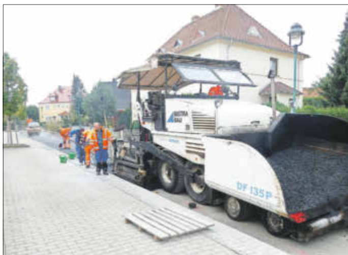
Asphalteinbau am 1. Oktober 2018, Foto: Ingenieurbüro Jehnen
