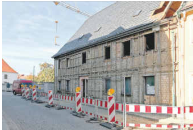
Das Gebäude auf der Böhmischen Straße 17 wurde bereits entkernt und für einen Rückbau vorbereitet
