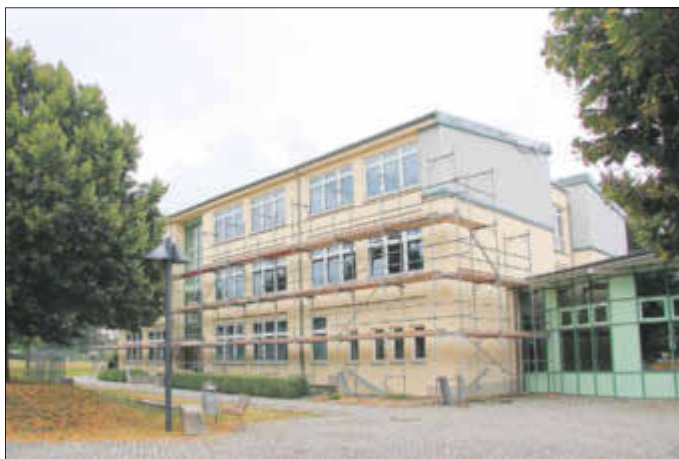
Eingerüstete Fassade am Anbau der Friedrich-Schiller-Oberschule
