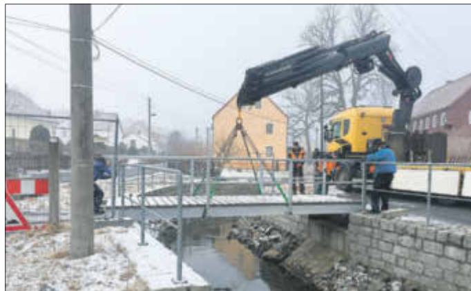
Montage der Stahlkonstruktion an der Fußgängerbrücke im Ortsteil Polenz, Foto: Metallbau Göttlich
