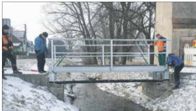
Und an der Fußgängerbrücke im Ortsteil Berthelsdorf am 21. März 2018 durch die Firma Metallbau Göttlich, Foto: Metallbau Göttlich
