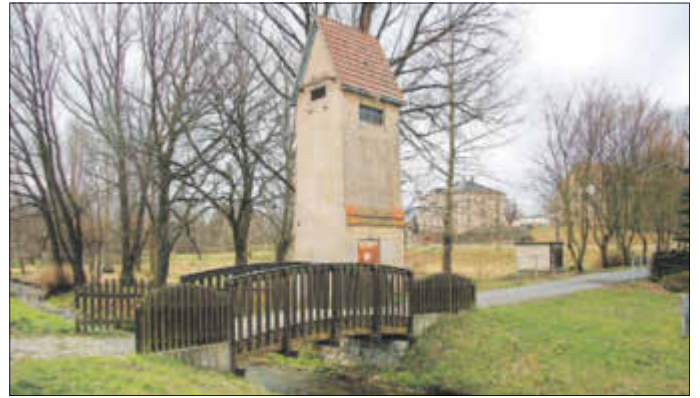
Im Ortsteil Berthelsdorf erhält diese Brücke eine neue Stahlkonstruktion
