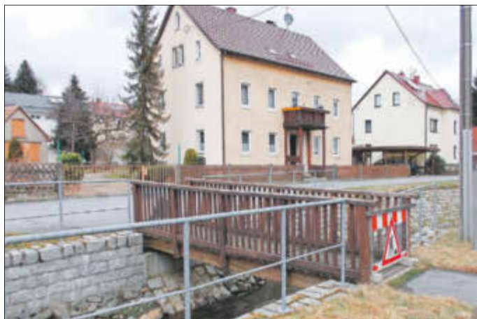
Die zu erneuernde Fußgängerbrücke im Ortsteil Polenz
