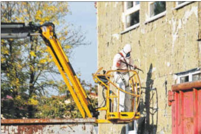
Abtragen der Fassade, des Putzes und des Dämmmaterials, Foto: W. Thalheim
