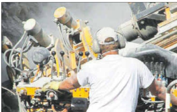
Harte Arbeit - Bohren der Rückverankerung Spritzbetonwand
