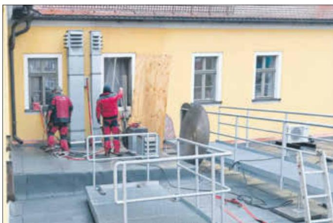
Herstellung des Rettungswegs bzw. Schaffung eines zusätzlichen Ausgangs für das 1. Obergeschoss über das Flachdach des Hofhauses
