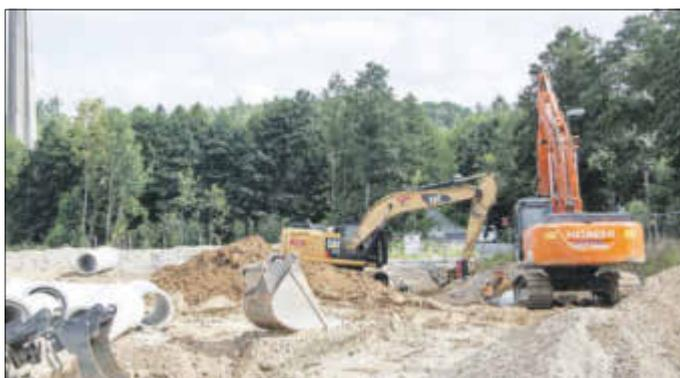
Bau des Hauptstranges der Regenwasserableitung entlang der Kirschallee zur Einleitung in das noch zu errichtende Regenrückhaltebecken
