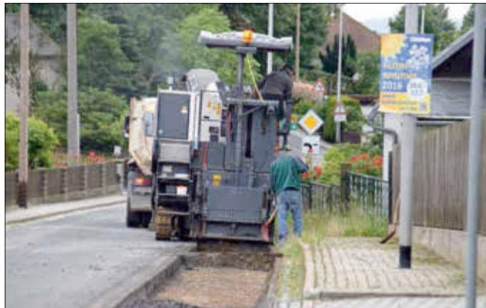
Abfräsen der alte Asphalttrag- und -deckschicht auf der Hauptstraße in Krumhermsdorf
