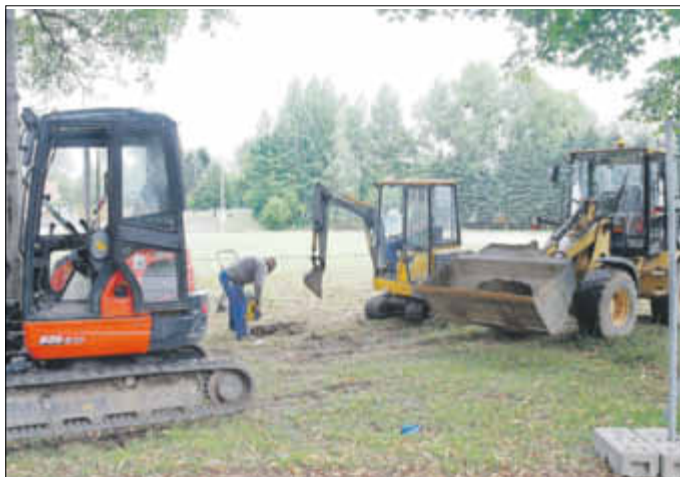
Einsetzen der Zaunsäulen für die neue Umzäunung am Stadion, Foto: W. Thalheim
