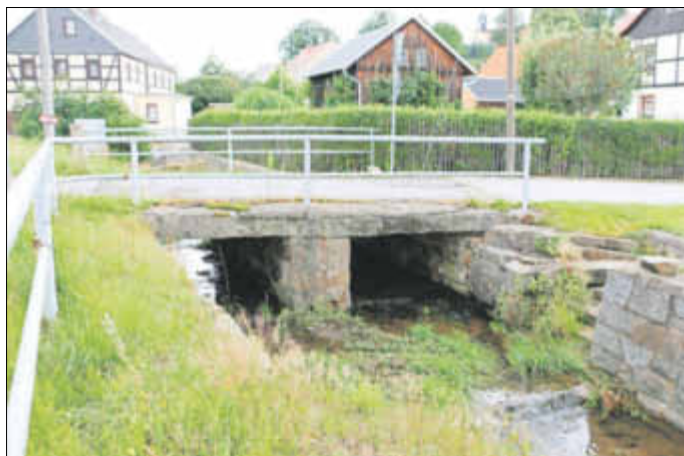
Brücke gegenüber der Bischofswerdaer Straße 275 im Ortsteil Niederottendorf
