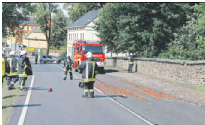
Aufräumen der heruntergefallenen Dachziegel am Schlossgelände nach dem Sturmschaden, Foto: W. Thalheim
