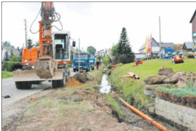
Beräumungsarbeiten der Gewässersohle am Mühlgraben
