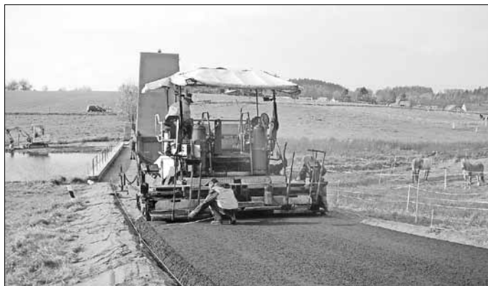
Aufbringen der Asphaltschicht in Krumhermsdorf am 23. Oktober 2013
