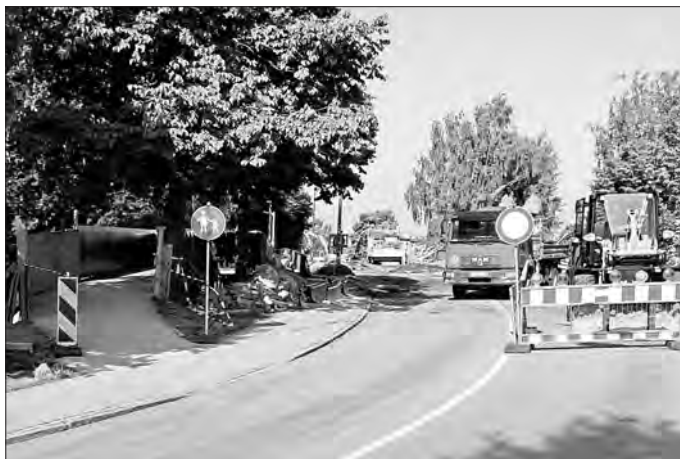
Vollgesperrte Maxim-Gorki-Brücke mit Fußweg (links im Bild)
