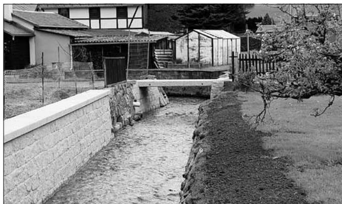
Die durch das Hochwasser im August 2010 beschädigte Stützmauer/Fußgängerbrücke „An der Lohe“ vor der Einmündung in die Straße „Valter“ wurde bis auf wenige Restleistungen (Geländerkonstruktionen) Ende April fertig gestellt. Neben der Erneuerung der Stützmauer und der
