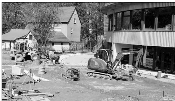
Der 1. Bauabschnitt, die Erschließung der Flächen am Eingangsbereich, wurde bis Ende April mit Ausnahme der Asphalt-Deckschicht fertig gestellt. Diese erfolgt technologisch bedingt mit der Realisierung der Rollerstrecke. Bauzeitgleich begann
