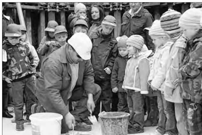
Die Kinder beobachten gespannt, wie der Vorarbeiter die Hülse versenkt und einbetoniert.
