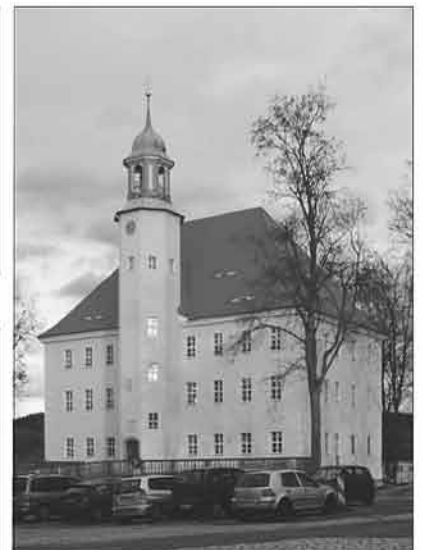
Fertigstellung der Sanierung des Schlosses Langburkersdorf, 1. und 2. Obergeschoss
