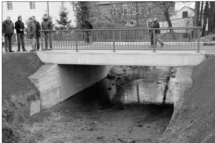
Die neue Brücke mit einem größeren Wasserdurchlass zum besseren Schutz gegen Hochwasser.
