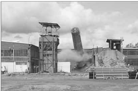
Sprengung des alten Schornsteins im ehemaligen Dachziegelwerk
