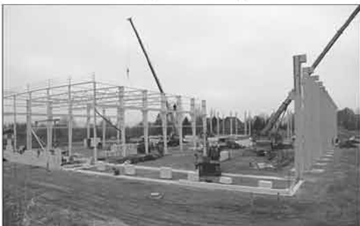
Die neue Produktionshalle von Veritas wächst.
