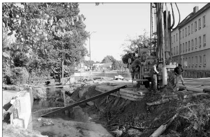
Verbauarbeiten mittels Bohrgerät an der Brücke Seifenweg
