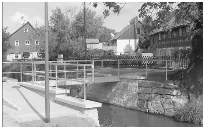
Fertig gestellte Brücke am Mittelweg in Polenz
