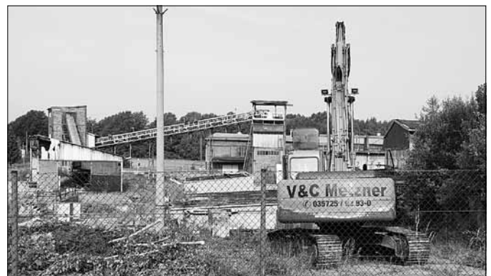
Vergangene Woche begann der Abbruch im ehemaligen Dachziegelwerkgelände.
